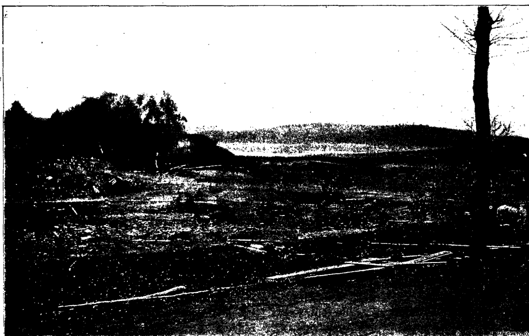
FIG. 3. — Brèche de la digue de Bouzey. — (Cliché de M. L. Geisler.)
